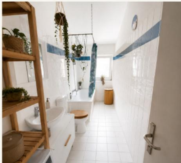
Bad im dokumentierten Bestand
