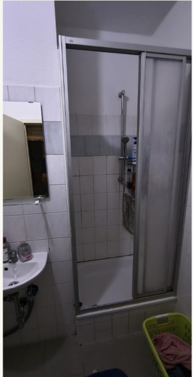
Duschbad im vorhandenen Zustand
